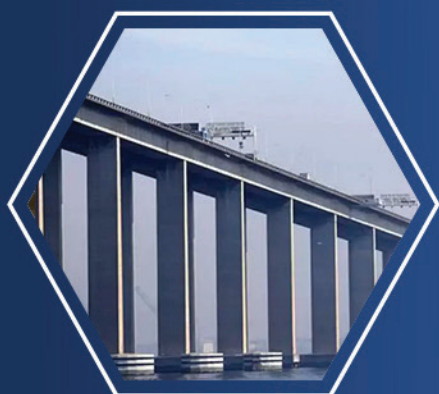
PONTE RIO NITERÓI
