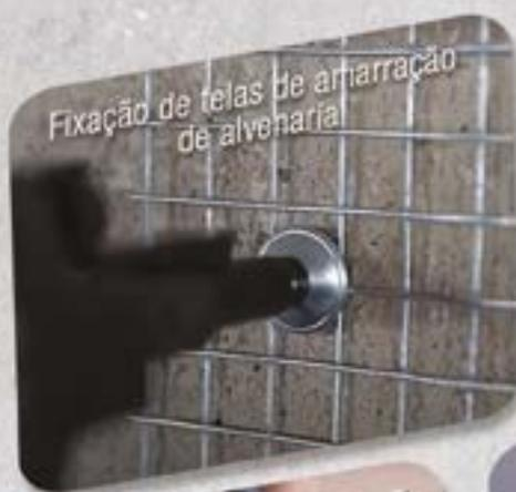
Fixação de telas de amarração de alvenaria
