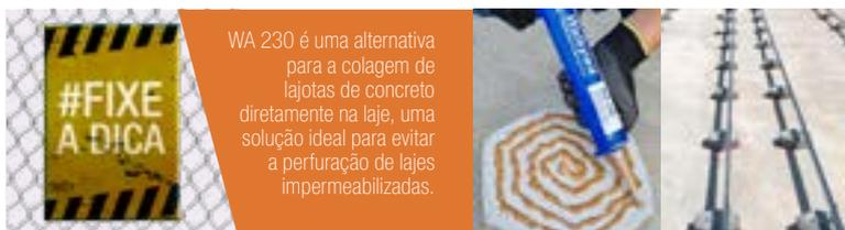
WA 230 é uma alternativa para a colagem de lajotas de concreto diretamente na laje, uma solução ideal para evitar a perfuração de lajes impermeabilizadas.
