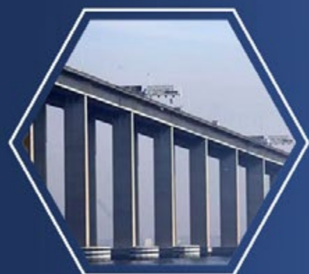
PONTE RIO NITERÓI
